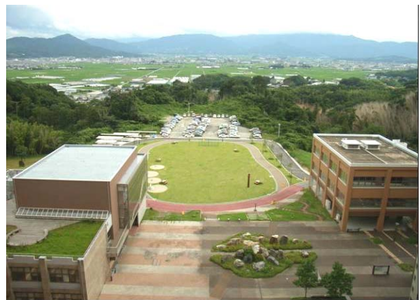
施工後の風景
