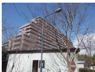
(改修前) 水銀灯 250W
