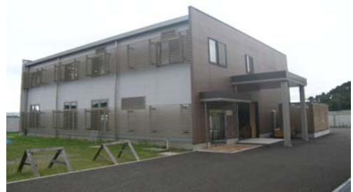
写真 1 エコセンター
